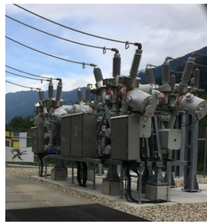
Anlage nach Erneuerung
